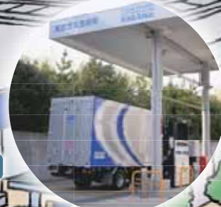
天然ガス充填スタンド
